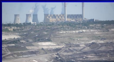
Degradacja terenu wokół kopalni węgla brunatnego w Bełchatowie.
